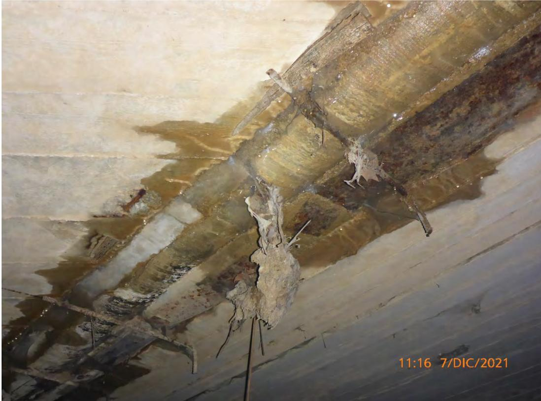
**Foto 5 tratto finale. Particolare di sottoservizio annegato nel solaio (Punto 36)**
