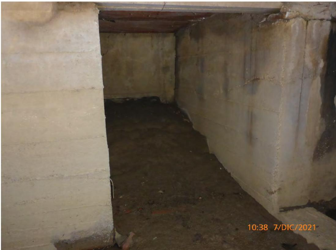
**Punto 19 immissione interrata e probabilmente non funzionante in Dx idraulica.**
