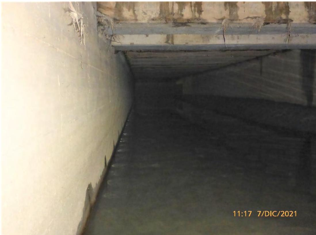
**Foto da punto 36 verso valle. Si intravedono in lontananza l'ultima curva a Sx., e l'immissione della canna rettangolare (Dx) che si collega al punto 34 (D1500 cls).**
