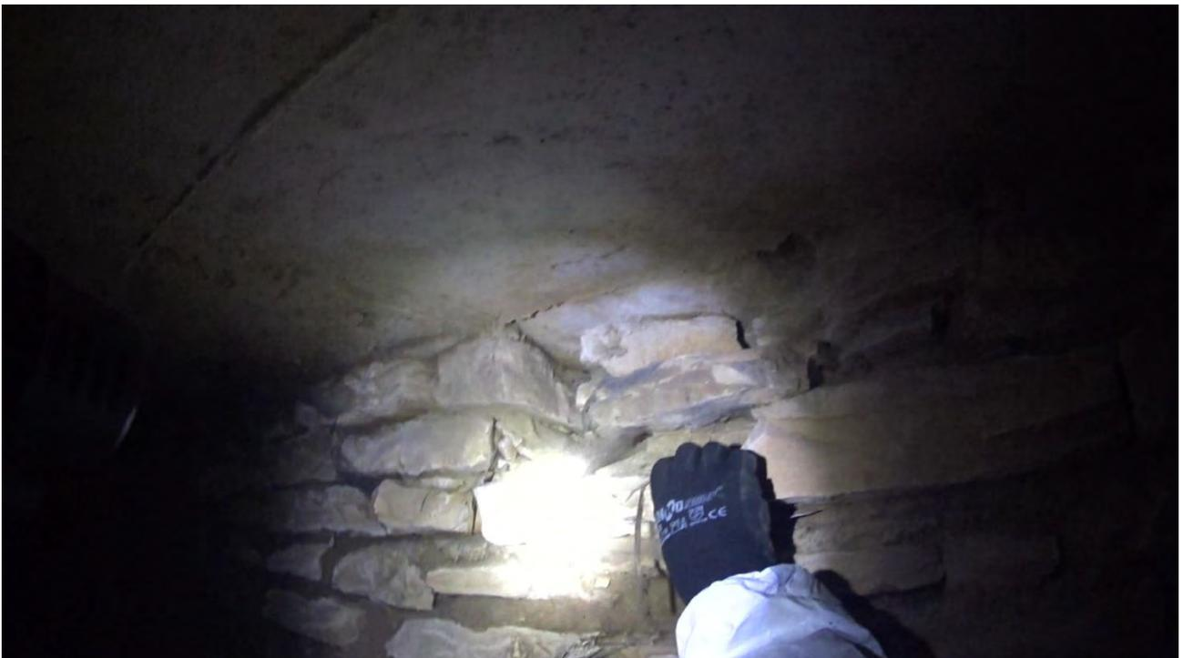
**Particolare della costruzione di parete superiore in scaglia calcare in Dx idraulica.**
