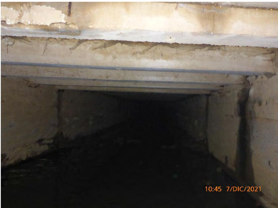
**Cambio sezione punto 23, da travetti accostati a travetti con tavelle.**
