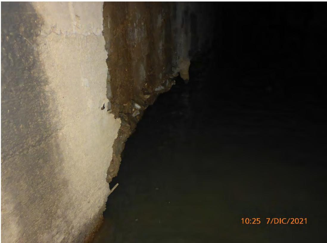
**Particolare cambio sezione punto 17 in Sx idraulica (no fondo).**
