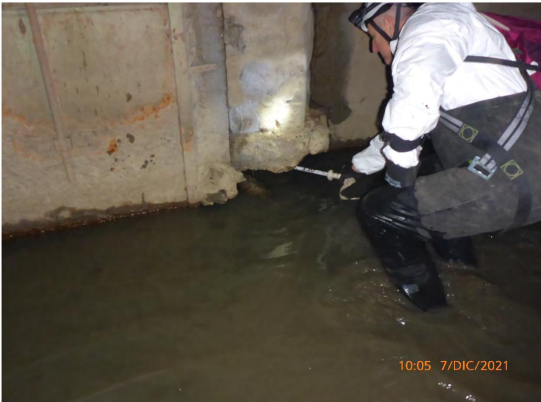
**Evidenziato danno strutturale fondamenta, in prossimità del punto 10 in Dx idraulica.**
