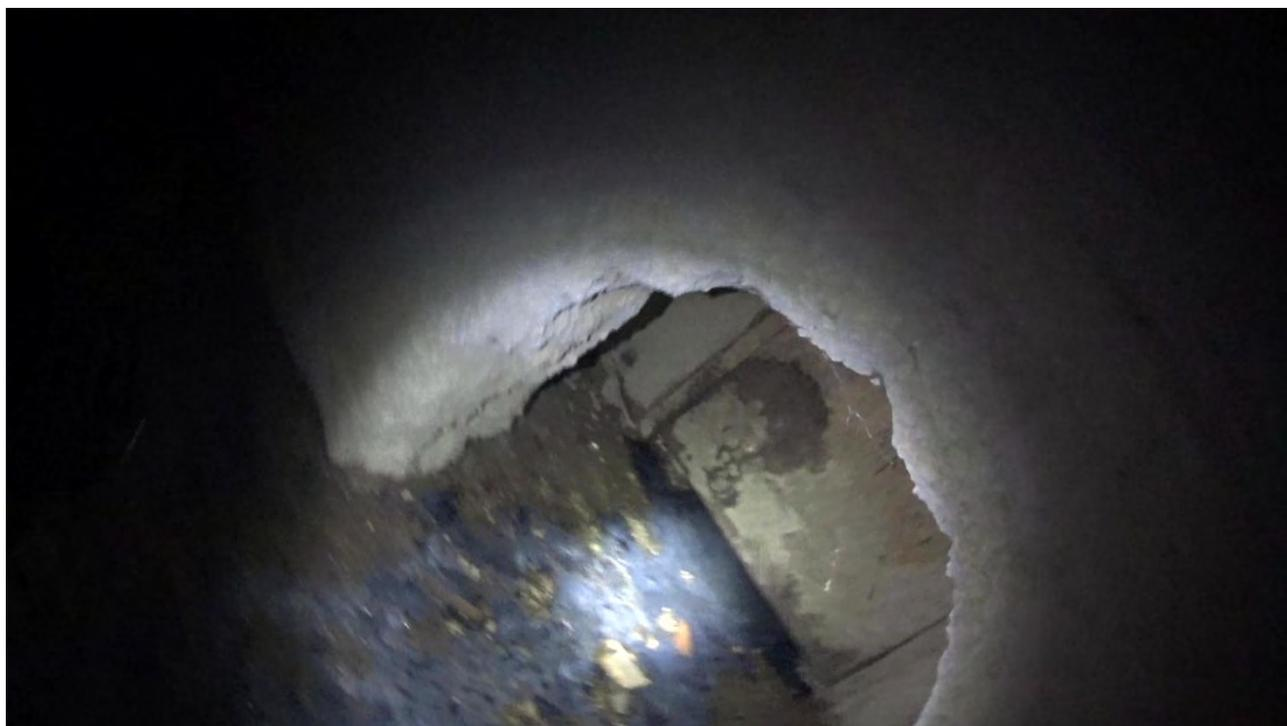
**Paratoia (punto 22) in Dx idraulica, si noti la presenza di fogna nere.**
